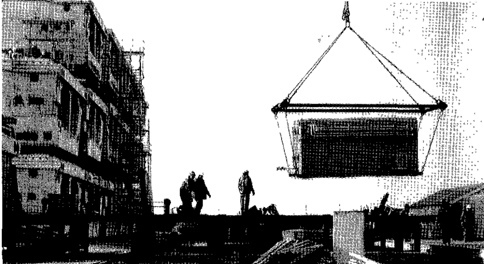
Invoer van een hydrauliek-container in een verkeerskoker
